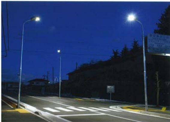
長野県諏訪郡富士見町交差点照明
