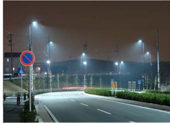
愛知県豊田市連続照明
